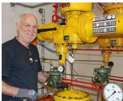
**RUNDERNEUERT** Auch die technischen Anlagen im BEW-Gasnetz müssen zur Umstellung auf H-Gas auf dem neuesten technischen Stand sein. Diese Gasregelanlage von 1982 in Hückeswagen-Raspenhaus (Foto) wurde gerade komplett erneuert. Sie „entspannt“ das unter Hochdruck stehende Ferngas auf Mitteldruck für die Haushalte. Helmut Hütt hat die Anlage bei der BEW 30 Jahre lang betreut. Inzwischen ist er Pensionär.
